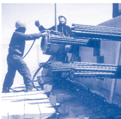
В случае коротких напрягаемых элементов особое внимание должно быть уделено потерям из-за притяжки клиньев, однако потери напряжения в этом случае из-за укорачивания напрягаемого элемента гораздо более высоки.
