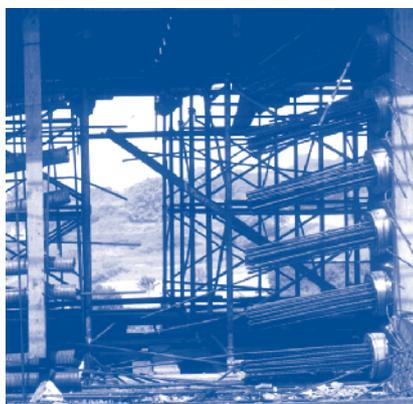
После напряжения, клин устанавливается в свой анкер при помощи гидравлического приспособления внутри домкрата. После того как домкрат отпускает канат, напрягаемое усилие передается с домкрата на плиту анкера.
